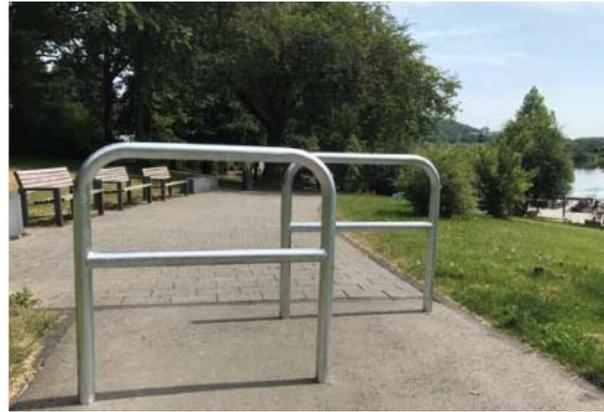
Stahlrohr Ø 60 x 2,5 mm
