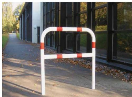
Stahlrohr Ø 48 x 2,5 mm
