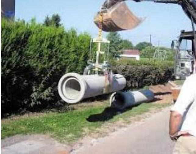
Durch extrem schlanke Bauweise auch einsetzbar in sehr schmalen Gräben. Mit auswechselbaren Greifbelägen, zur schonenden Aufnahme von beschichteten Rohren oder Steinzeugrohren.
